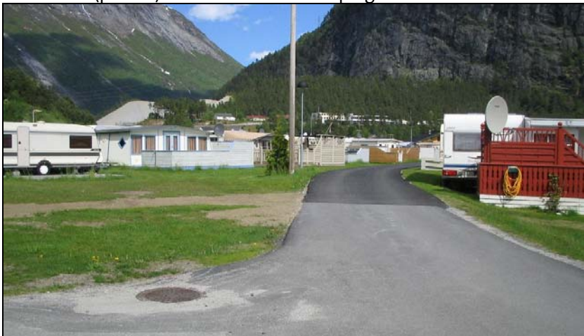
Bildet over: Tilkomstveg inn i Muri Camping, asfaltert hovud-internveg.
