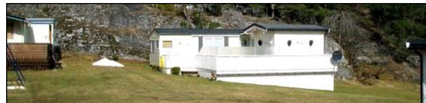
Oppbygging av platting og villavogn i skrånande terreng på Vika camping. Ideelt sett burde vogna vore plassert parallelt med skråninga i staden for vinkelrett på.
