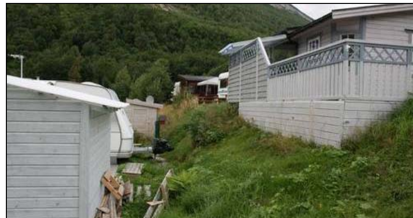
Horisontalavstand mellom faste konstruksjonar må vere minst 8 m – i dette høvet her på Jemtegård er truleg for liten avstand.
