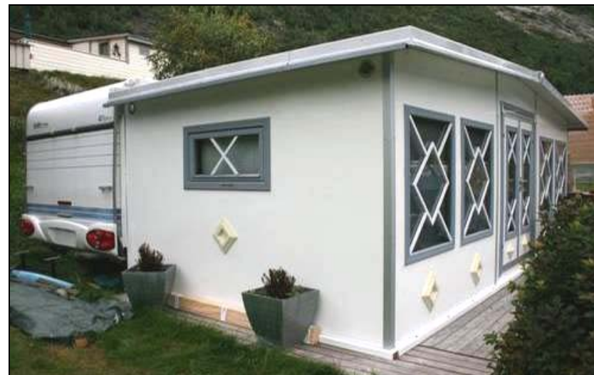
Sjølv om isoplast-telt er demonterbart, kan det ikkje demonterast raskt nok ved branntilløp, og må derfor definerast som ein fast konstruksjon i høve til brann.
